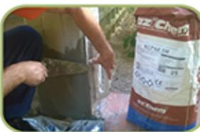
Το **REPAR SM** είναι ένα λεπτόκοκκο, θιξοτροπικό, ταχύπηκτο και εύπλαστο κονίαμα ανθεκτικό στο νερό, στις θερμικές μεταβολές και σε θεικά άλατα. Χρησιμοποιείται σαν ένα λεπτό στρώμα εξομάλυνσης και προστασίας σε επιφάνειες οπλισμένου ή μη σκυροδέματος.
