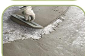
Το **FLOOR TENAX** είναι μια πολύ ισχυρή ταχύπηκτη ινοπλισμένη τσιμεντοκονία για την κατασκευή ανθεκτικών δομικών τσιμεντοειδών επιστρώσεων με περιορισμένο πάχος (1-4cm). Μπορεί να εφαρμοστεί σε Βιομηχανικά Δάπεδα, Διόδια κλπ.
