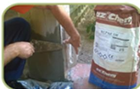
Το **REPAR SM** είναι ένα λεπτόκοκκο, θιζοτροπικό, ταχύπηκτο και εύπλαστο κονίαμα ανθεκτικό στο νερό, στις θερμικές μεταβολές και σε θειικά άλατα. Χρησιμοποιείται σαν ένα λεπτό στρώμα εξομάλυνσης και προστασίας σε επιφάνειες οπλισμένου ή μη σκυροδέματος.
