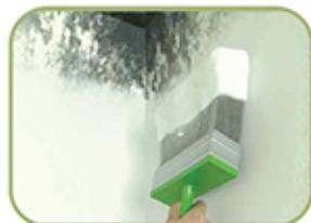
Το **C.W.C. STOP CONDENSE** είναι ένα επίχρισμα με μονωτικά χαρακτηριστικά του διατηρεί τις επιφάνειες θερμότερες κλείνοντας τις θερμογέφυρες ώστε να μην επιτρέπει τη συμπύκνωση των υδρατμών και τη δημιουργία της μούχλας.
