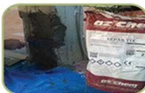
Το **REPAR TIX** είναι ένα θιζοτροπικό, ινοπλισμένο, επισκευαστικό κονίαμα οπλισμένου σκυροδέματος, πλήρους ελεγχόμενης συρρίκνωσης, ανθεκτικό σε θειικά, με υψηλή πρόσφυση καθώς και πολύ χαμηλή διαπερατότητα σε διοξείδιο του άνθρακα, όξινη βροχή και θαλασσινό νερό.
