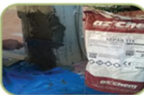
Το **REPAR TIX** είναι ένα θιξοτροπικό, ινοπλισμένο, επισκευαστικό κονίαμα οπλισμένου σκυροδέματος, πλήρους ελεγχόμενης συρρίκνωσης, ανθεκτικό σε θεικά, με υψηλή πρόσφυση καθώς και πολύ χαμηλή διαπερατότητα σε διοξείδιο του άνθρακα, όχινη βροχή και θαλασσινό νερό.
