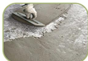
Το **FLOOR TENAX** είναι μια πολύ ισχυρή ταχύπηκτη ινοπλισμένη τσιμεντοκονία για την κατασκευή ανθεκτικών δομικών τσιμεντοειδών επιστρώσεων με περιορισμένο πάχος (1-4cm). Μπορεί να εφαρμοστεί σε Βιομηχανικά Δάπεδα, Διόδια κλπ.
