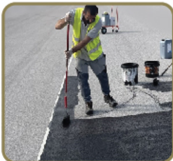
ΕΠΙΣΚΕΥΑΣΤΙΚΟ ΓΑΛΑΚΤΩΜΑ ΕΠΙΣΤΡΩΣΗΣ
