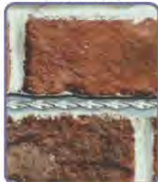
ΣΥΝΔΕΣΜΟΙ ΑΠΟ ΑΝΟΞΕΙΔΩΤΟ ΧΑΛΥΒΑ ΓΙΑ ΕΠΙΣΚΕΥΕΣ ΚΑΙ ΕΝΙΣΧΥΣΕΙΣ
