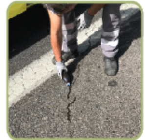
ΑΣΦΑΛΤΙΚΟ ΓΑΛΑΚΤΩΜΑ ΠΛΗΡΩΣΗΣ ΡΩΓΜΩΝ
