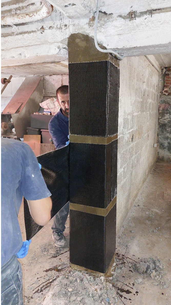
11. Ενίσχυση υποστηλώματος με FRP
