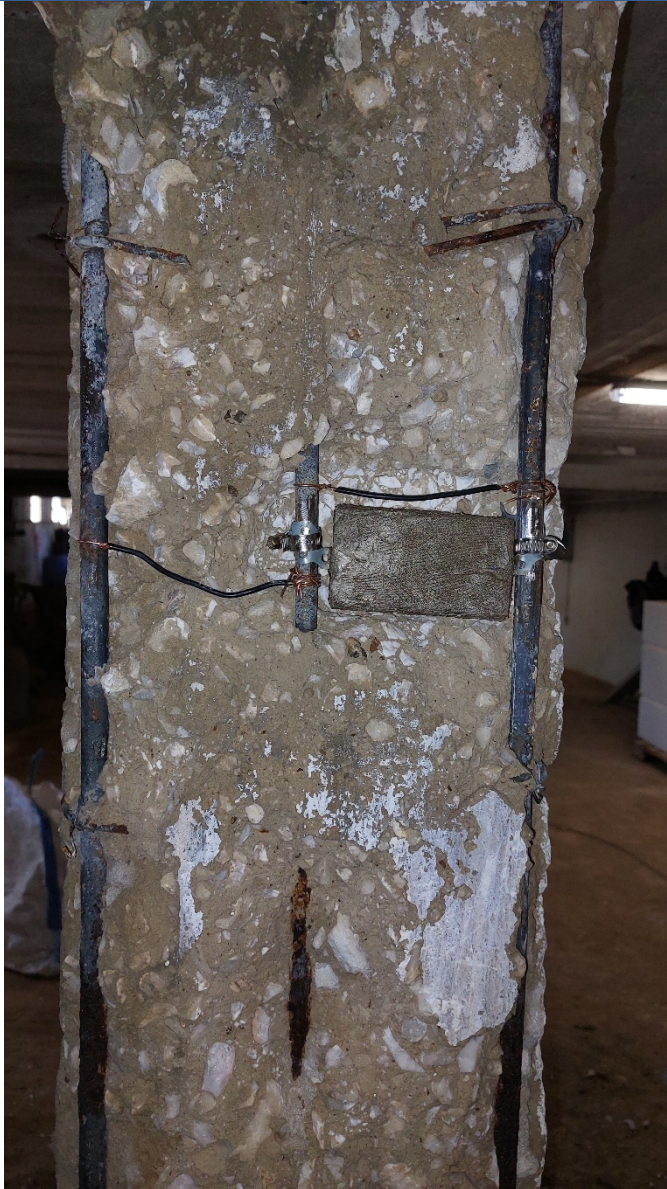
4. Σύνδεση οπλισμών με καλώδιο και τοποθέτηση Ανοδίου
