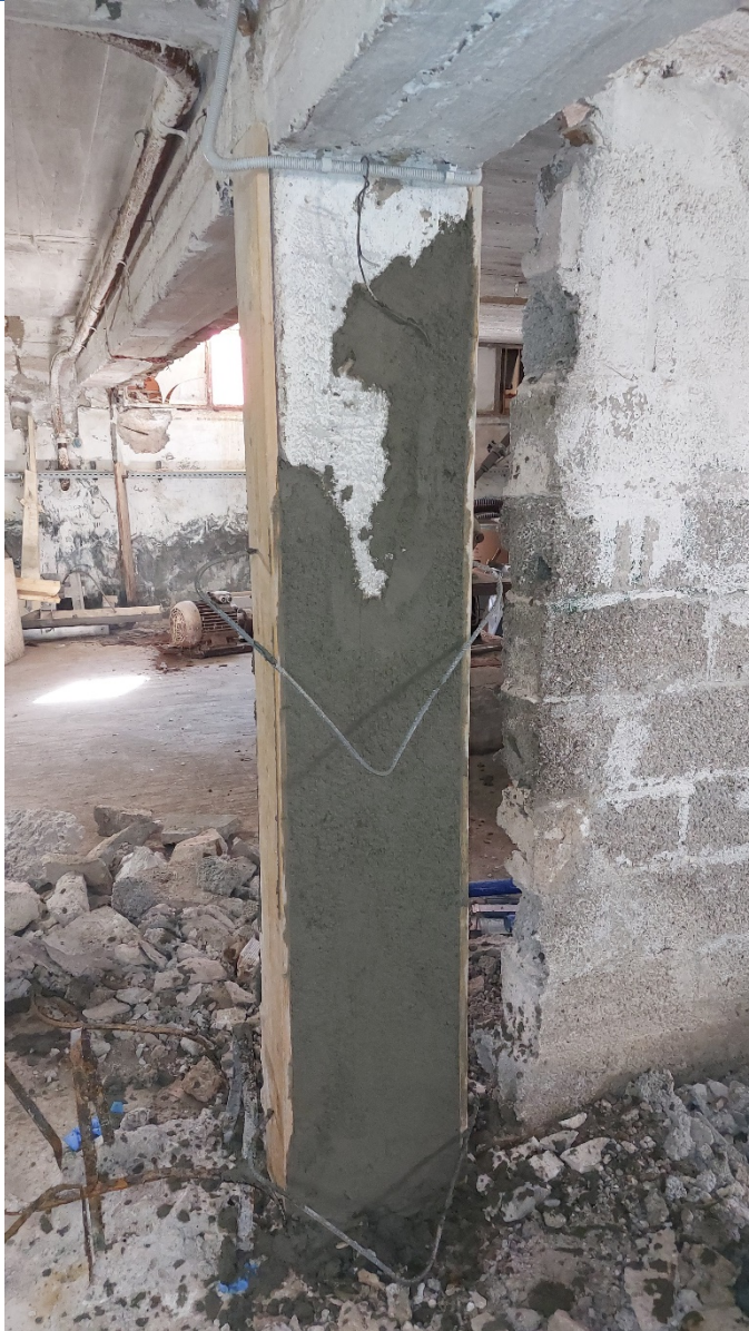
9. Αποκατάσταση διατομής του υποστηλώματος με επισκευαστικό κονίαμα R4
