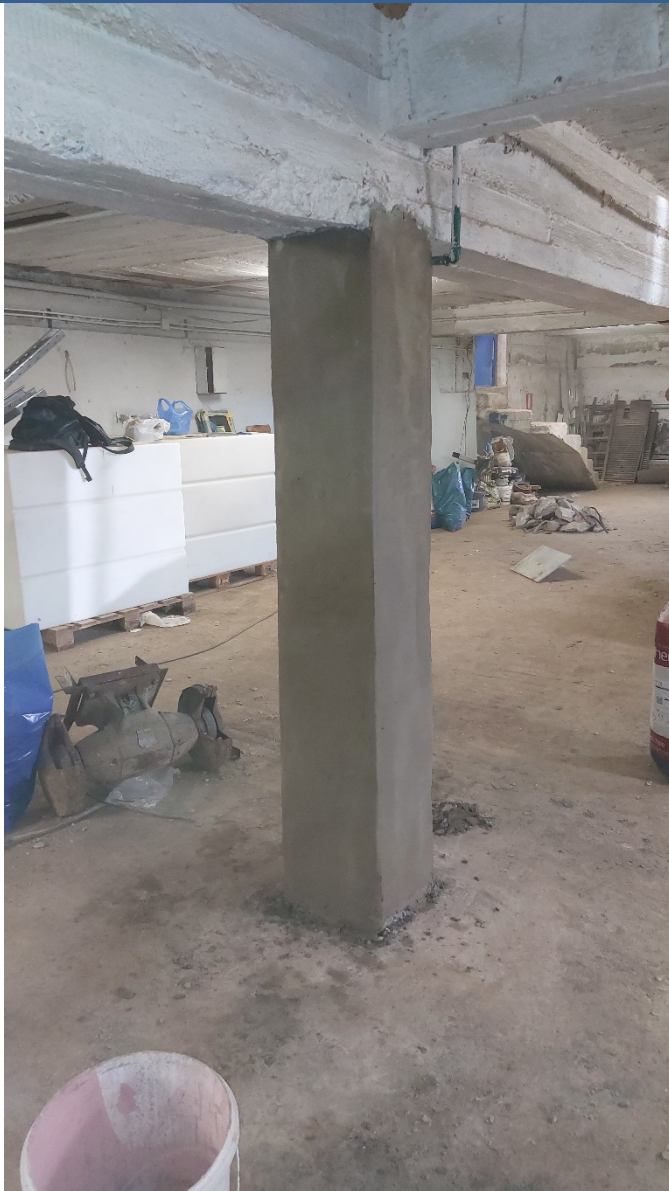
10. Επίστρωση υποστηλώματος με επισκευαστικό κονίαμα R4
