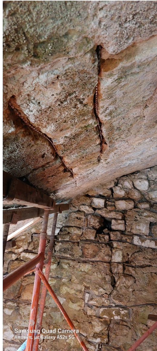
5. Τοποθέτηση ελικοειδών βλήτρων σε γωνία τοιχοποιίας
