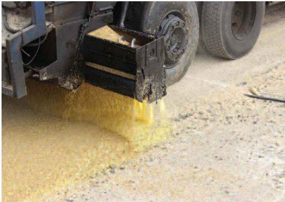
2. Εφαρμογή του Emulcolorbit Plus και αμμώδους με χρήση Bitem συνδυαστικής μηχανής.
