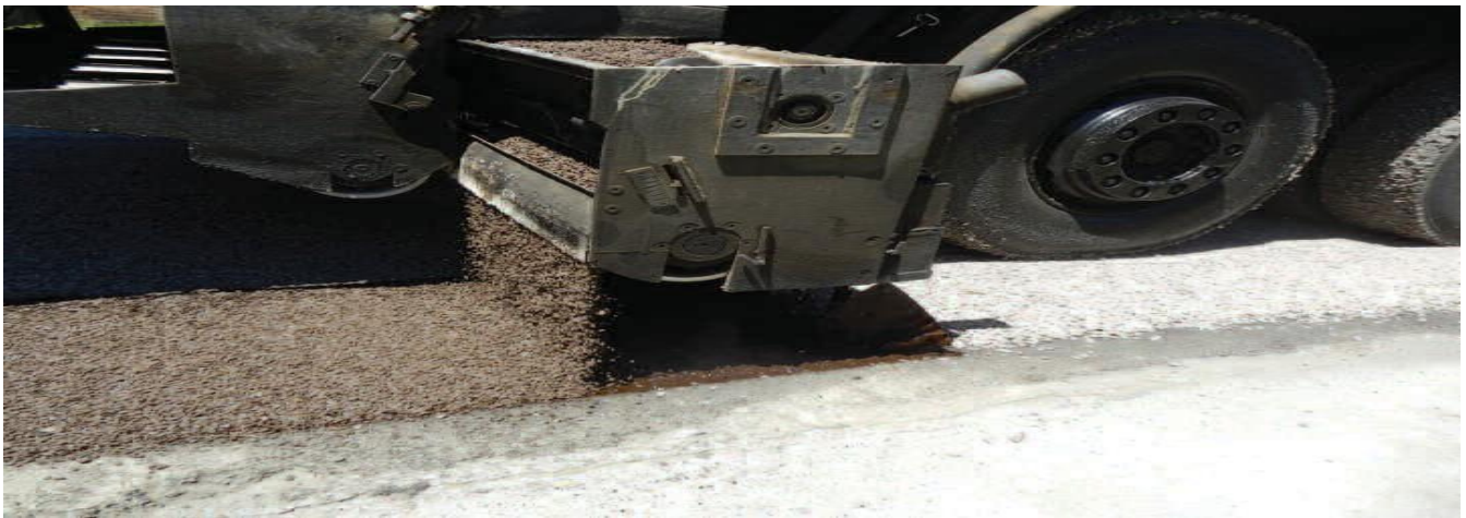
1. Εφαρμογή του Bitemulsione 69 TS και ψηφίδας με χρήση Bitem συνδυαστικής μηχανής.
