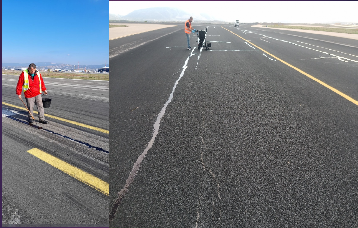
BITEMSEAL – Επισκευή ρωγμών
