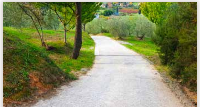
LUCCA (LU) Driveway flooring at Tenuta dello Scompiglio (2015)
