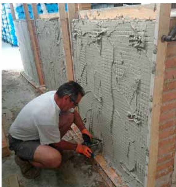
Realizzazione dei muretti e l'applicazione dei sistemi di rinforzo costituiti da rete bidirezionale in fibra di vetro Ar Glass e matrice inorganica a base calce idraulica.
