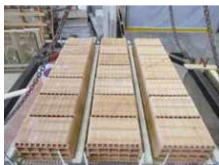
REALIZZAZIONE DEL SOLAIO
