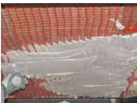
APPLICAZIONE DELL'INTONACO STRUTTURALE
