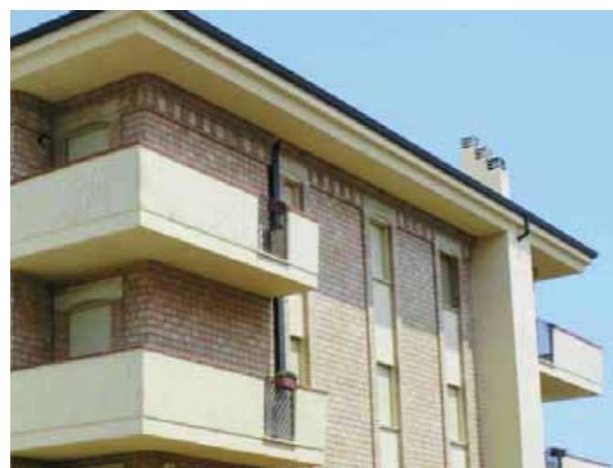
Esempio di parete perimetrale monostrato ad intercapedine continua e rivestimento esterno in listelli faccia vista (isolamento esterno a cappotto)
